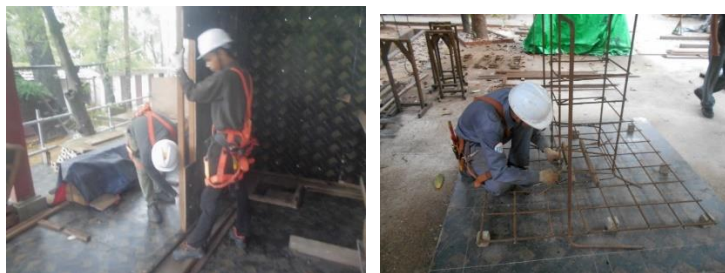
型枠工訓練(柱・梁・壁・スラブ建て込み)
