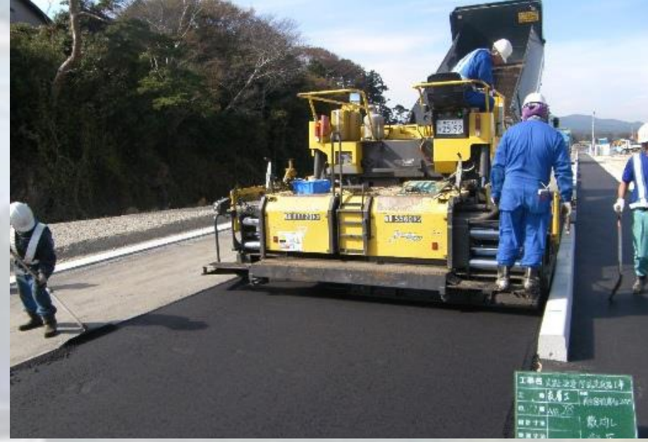
インフラ整備工事
